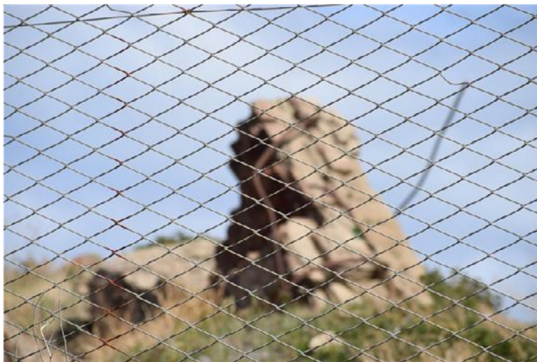
Figura 5: Escombros desplazados , Sol Panizza (2018). Fuente: Registro propio.
